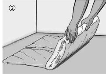
Grundsätzlich ist bei allen Estrichen und bei Verlegung auf Fußbodenheizung eine 0,2 mm starke PE-Folie – SD größer 75m auszulegen. Diese muss im Stoßbereich 30 cm überlappen. Anschließend die Folie auf Höhe des Bodenbelags abtrennen. Da der Boden bereits eine integrierte Korkdämmunterlage hat, darf keine zusätzliche Dämmunterlage ausgelegt werden.
