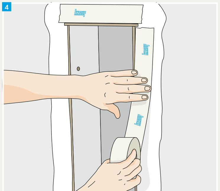
Die Einbauteile sind wasserfest verklebt und können problemlos verspachtelt werden. Für einen rissfreien Übergang müssen die Fugen rund um die Wandnischen mit Knauf Uniflott **3** und Knauf Fugendeckstreifen Kurt **4** verspachtelt werden. Ein anderer Fugendeckstreifen, z. B. aus Glasfaser ist hierfür nicht geeignet.
