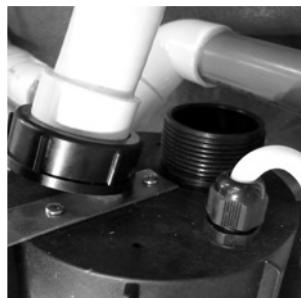
Ukoliko je Vaš masažni bazen opremljen puhalicom, priključak je potrebno spojiti i provjeriti stabilnost prije prvog puštanja u rad.
