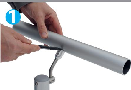
Handlauf an bereits vormontiertem Handlaufhalter positionieren und anzeichnen.
