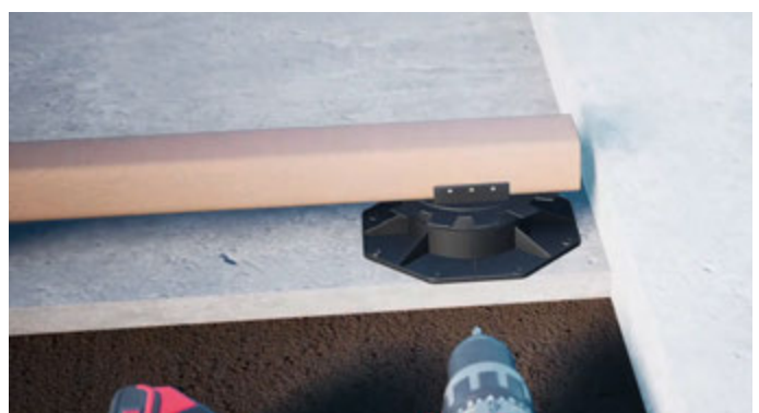
M Befestigung der Stelzlager und der Unterkonstruktion
