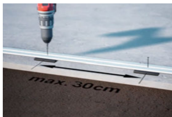
K Abstand zwischen Auflagenpads/Steltzlagern
