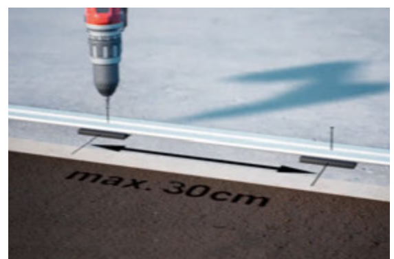
N Abstand zwischen Auflagenpads/Betonplatten
