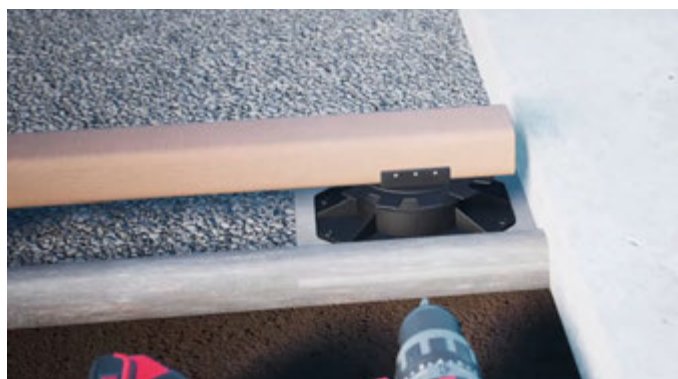
O Befestigung der Stelzlager und der Unterkonstruktion
