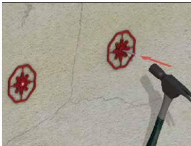
**Abb. 14: Setzen der Baumit KlebeAnker mittels Hammer**
