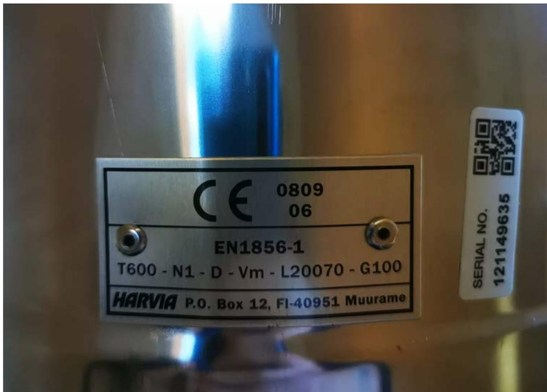
Abbildung 12: Typenschild mit CE-Kennzeichnung Edelstahlschornstein WHP 1500
