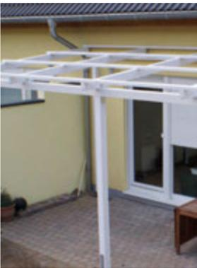
Wellplatten werden auf statisch tragenden Unterstützungen (Pfetten) verlegt, die quer zum Gefälle- bzw. zur Wasserlaufrichtung liegen. Der Abstand zwischen den einzelnen Pfetten darf – abhängig vom Plattenprofil – ein bestimmtes vorgeschriebenes Maß nicht überschreiten (siehe Tabelle Pfettenabstände).
