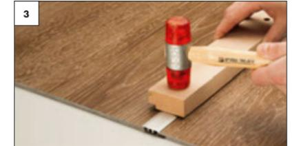
3 Beim Fixieren unbedingt ein Schlagholz längs unterlegen. Das Profil rastet so weit ein bis es dicht an beiden Seiten anliegt.
