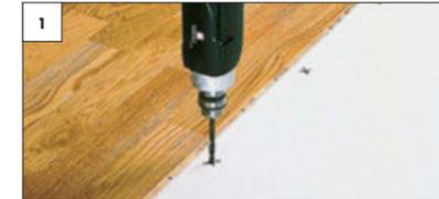
1 Unter Berücksichtigung der Dehnfuge Bohrlöcher mit einem Durchmesser von 6 mm bohren.
