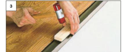
3 D.O.S. Profil und Dübel zusammen fest in die Bohrlöcher drücken. Dübel gleichmäßig in die Bohrlöcher eintreiben.
