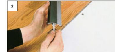
2 Die Dübel in die Aufnahme schieben. Alle beige packten Dübel verwenden.
