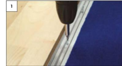
1 Basisprofil auf dem Untergrund verschrauben oder verkleben. Wir empfehlen, es zu verschrauben.
