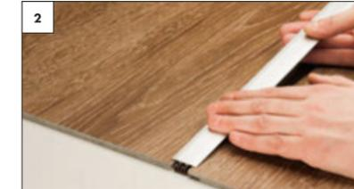
2 Unter Handdruck das Oberprofil in das Basisprofil drücken bis es eingerastet ist.
