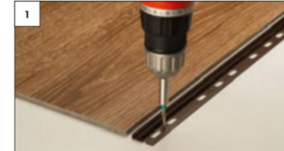
1 Basisprofil auf dem Untergrund verschrauben oder verkleben. Wir empfehlen, es zu verschrauben.
