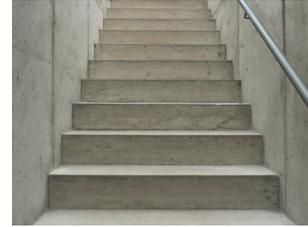
Die wichtigste Voraussetzung für eine lang anhaltende Schutzwirkung ist eine optimale Vorbereitung. Achten Sie stets darauf, dass der Untergrund trag- und haftfähig, sauber (staub-, öl-, wachs- und fettfrei), fest und trocken ist. Reinigen Sie alte, intakte
