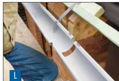
Die Rinnen werden mit einer Verbindungsschale zusammengesteckt. Der richtige Abstand der Rinnenenden ergibt sich aus den Markierungen auf der Verbindungsschale. Wichtig: Bei gekürzter Rinne muss die Nut eingearbeitet werden.
