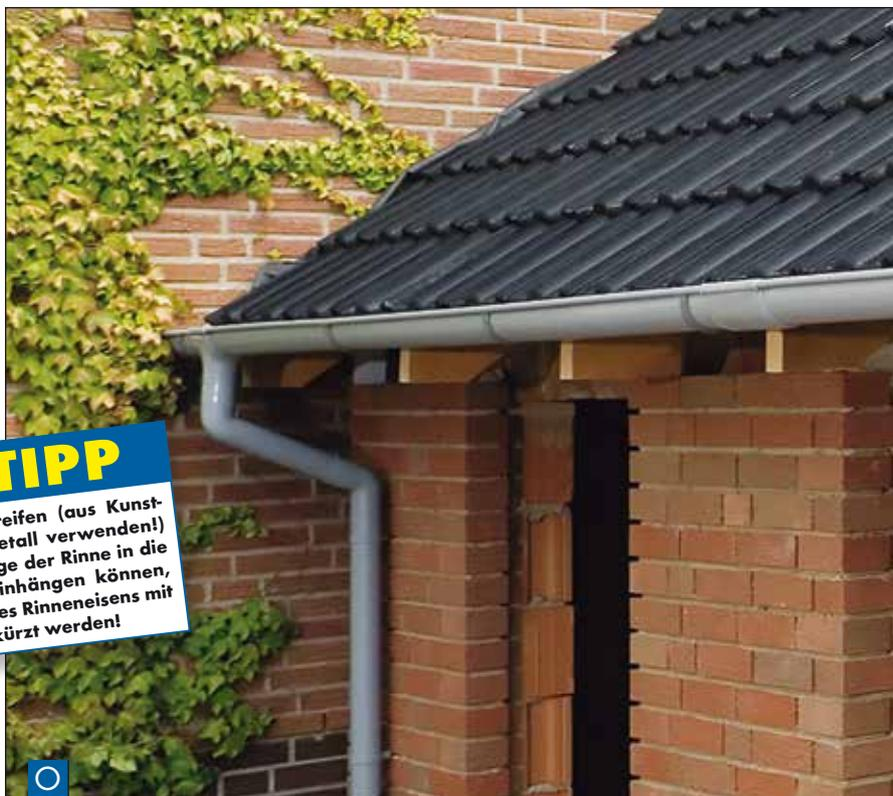
Die Traufstreifen bieten zusätzlichen Schutz vor Regenwasser und Flugschnee. Sie werden in die Abkantung der Dachrinne eingehängt und mit Pappstiften alle 30 cm auf der Dachlatte festgenagelt. Traufstreifen werden mit einer Überlappung von mindestens 4 cm verlegt.
