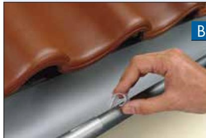
Die Befestigungsklips werden im Abstand von ca. 40 cm auf den vorderen Wulst der Dachrinne aufgeschoben.
