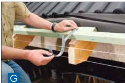
**G** Die abgelenkten Rinneneisen in den Aussparungen an der Dachlatte mit Spaxschrauben oder entsprechenden Nägeln befestigen. Tipp: Stirnbrett bei zu großen Sparrenabständen benutzen!
