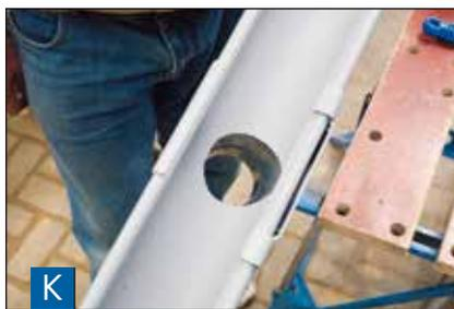
Die Sägekante entgraten und den Rinnestützen über die hintere Abkantung einhängen und über den vorderen Wulst klippen.
