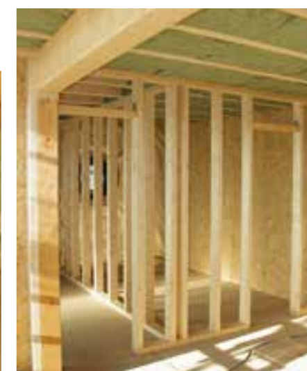
Das vorgefertigte Rahmenwerk einer Innenwand wird erst auf der Baustelle gedämmt und beplankt.
