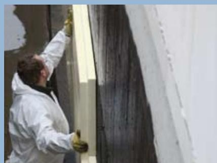
Verarbeitung der URSA XPS Dämmplatten an der Kelleraußenwand.
