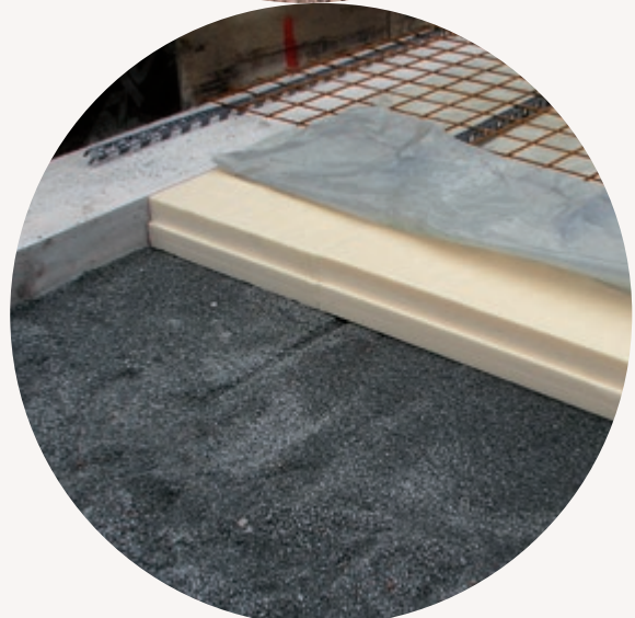
URSA XPS D N-III-L in 160 mm unter einer Bodenplatte mit Streifenfundamenten
