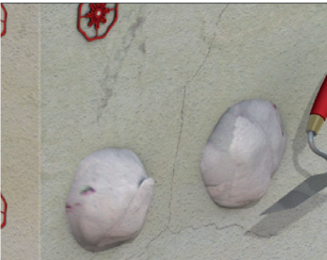
Abb. 17: Anwerfen der Kleberpatzen
