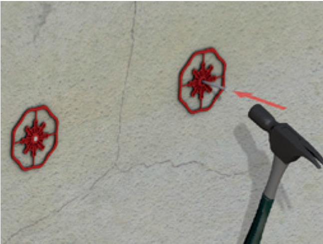
Abb. 15: Setzen der Baumit KlebeAnker mittels Hammer
