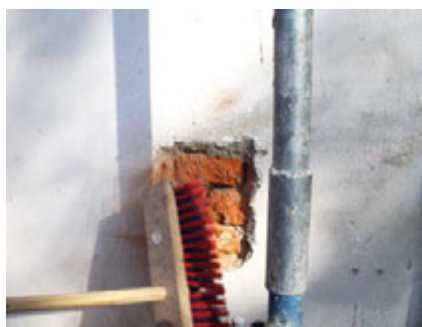
Putzfehlstellen reinigen
