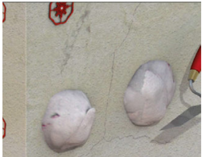
Abb. 17: Anwerfen der Kleberpatzen
