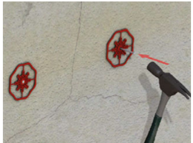
Abb. 15: Setzen der Baumit KlebeAnker mittels Hammer
