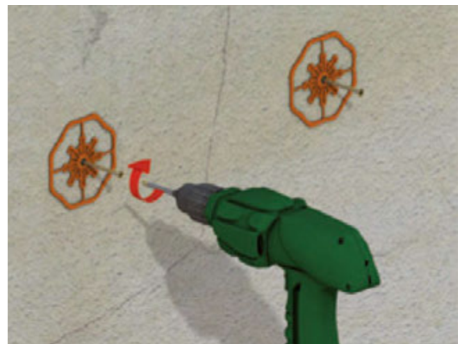
Abb. 16: Setzen der Baumit KlebeAnker mittels Bohrschrauber
