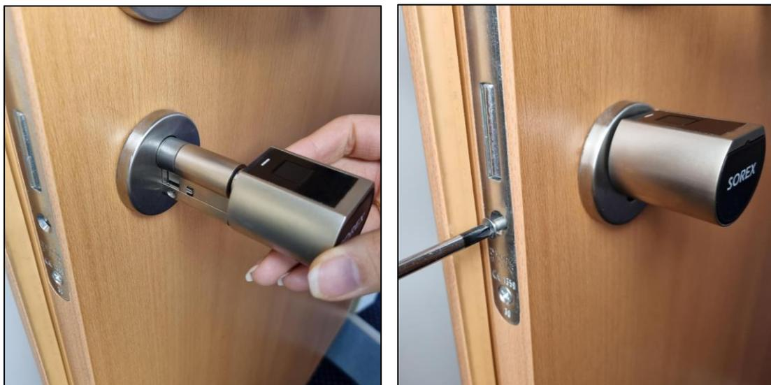
Wenn Sie den Zylinder mittels der Zentrierschraube an der Tür befestigt haben, können Sie den **Innenknopf** wieder **montieren**. Hier können Sie noch einmal die **Länge** des **Zylinders variieren** und anschließend mit der Schraube und dem mitgelieferten **Inbusschlüssel festziehen**.
