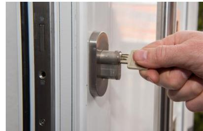
Jetzt können Sie den FLEX Fingerprint Zylinder von außen nach innen durch das Schloss durchschieben. Achten Sie darauf, dass sich der Fingerprint-Teil auf der Außenseite der Tür befindet. Nachdem der Zylinder in der Tür angebracht wurde, müssen Sie die Zentrierschraube wieder fixieren.
