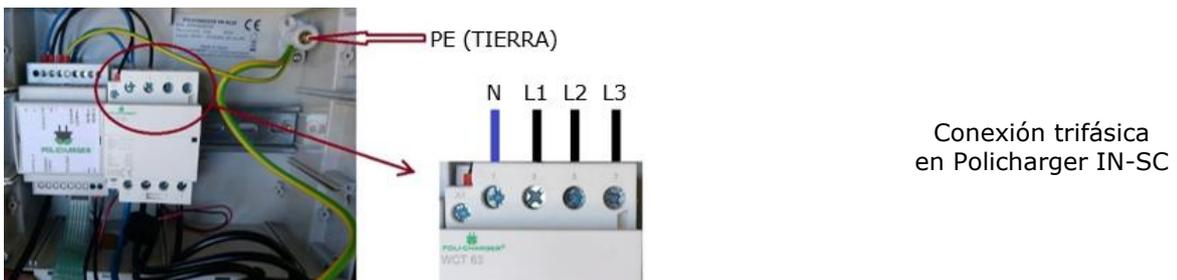
No se olvide de conectar el cable de tierra (PE) a su terminal correspondiente.
