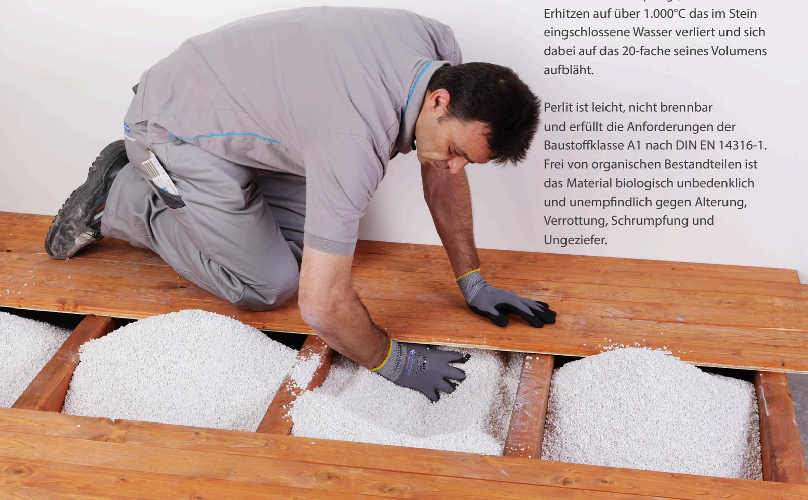
Die Dämmstoffschüttung Isoself® besteht aus staubgebundenem Perlit. Hierbei handelt es sich um expandiertes Rohperlit rein vulkanischem Ursprungs, das durch Erhitzen auf über 1.000°C das im Stein eingeschlossene Wasser verliert und sich dabei auf das 20-fache seines Volumens aufbläht.
