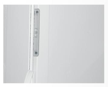
**Schritt 1:**Dichtungsgummi bis unterhalb des Schließblechs aus der Zarge lösen. Dann das Schließblech durch Lösen der Schrauben entfernen.
