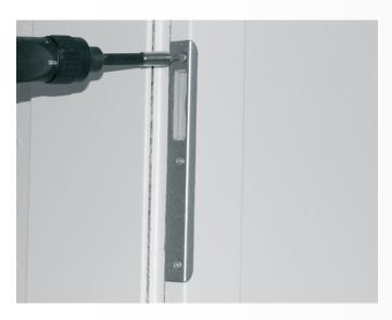
Schritt 3: Neues Schließblech mit Schrauben auf der Unterfütterung befestigen.
