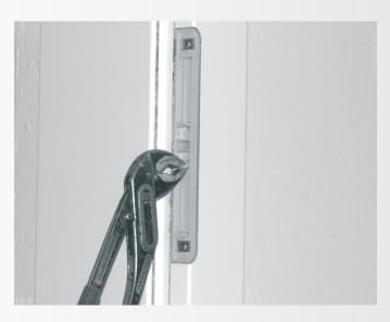
Schritt 2: Entfernen der unteren Kunststoffstege (bei abschließbaren Ganzglastüren ist eine Nacharbeit des oberen Fallenlochs notwendig).
