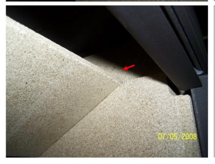
Vermiculite oben Deckel auf Bauteil Vermiculite oben li / re ablegen und nach hinten an den Korpus schieben.
