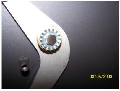
Sechskantschraube am Abgasgetänge wird abgeschliffen, um bei Glasverkleidung ein Schaben an der Hinterdruckung zu vermeiden.
