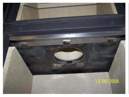
Bild zeigt korrekte Lage des Scheibenspülblechs für unteren Brennraum.
