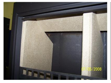
Vermiculite oben Deckel anheben und Vermiculite oben li / re in darunter schieben, sodass Vermiculite oben Deckel auf den Bauteilen Vermiculite oben li / re aufliegt.
