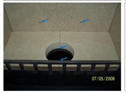
Bild zeigt korrekte Pos. der Schamotte oben Boden.
