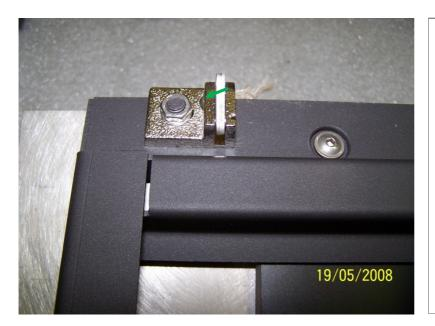
Scharnier Tür mit Schlitz an oberster Position montieren.
