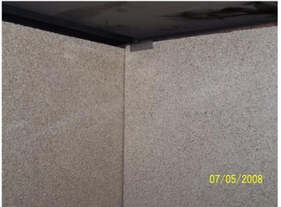
Bild zeigt korrekte Lage des Bauteils Halteblech Vermculite unten.
