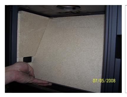
Vermiculite unten Hinten von unten in das Halteblech Vermiculite einschieben.
