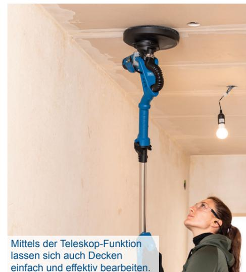
Mittels der Teleskop-Funktion lassen sich auch Decken einfach und effektiv bearbeiten.
