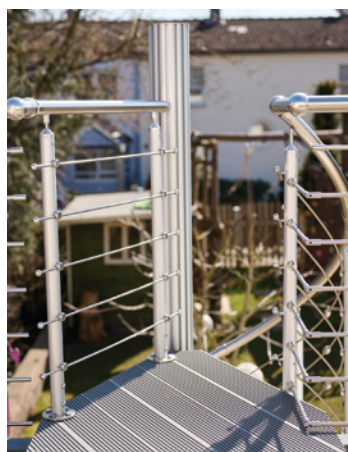
Podest und Podestgeländer
