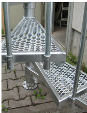
Befestigung der Geländerstäbe an den Gitterrost-Stufen und Standrohr am Boden
