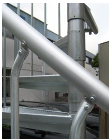
Befestigung des Handlaufs an den Geländerstäben
