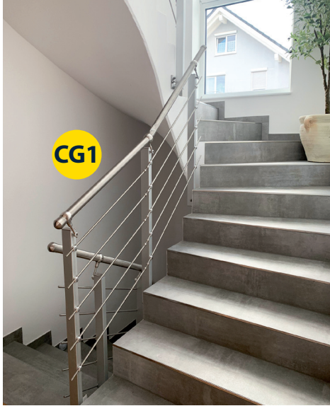
Geländerhöhe 900mm, 5 Füllstäbe
