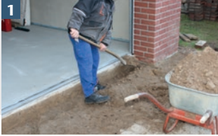
1 Bodenaushub nach Einbauempfehlung für ACO Self® Standardline: Rinnenstrang mit Einlaufkasten
