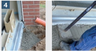
4 Einbringen des Rinnenfundamentes gemäß Einbauempfehlung. Verdichten des Rinnenfundamentes. Vorbereiten des Ablaufes für KG-Rohr DN/OD 110
