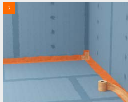
In die feuchte Flüssigfolie das fermacell™ Dichtband eindrücken
