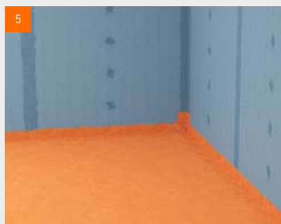
Vollflächige Abdichtung der Fläche im Bereich W1-I
