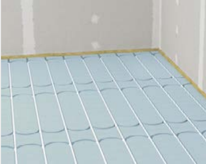
Einlegen der 16 mm Fußbodenheizrohre
