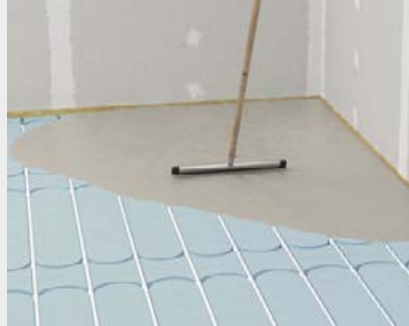
Ausgießen der Therm25™ Elemente mit fermacell™ Ansetzbinder
