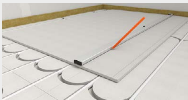
Anzeichnen der Befestigungspunkte und -achsen. Markieren der Befestigungspunkte.
