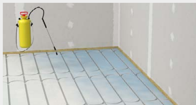
Grundierung der fermacell® Therm25™ Elemente mit fermacell™ Tiefengrund
