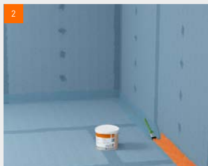
fermacell™ Flüssigfolie in der Ecke auftragen
