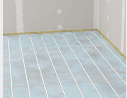
Fertig ausgegossene Therm25™ Elemente (Q1)
