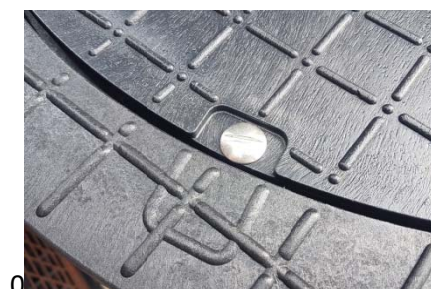
Teleskopschachtabdeckung mit Verschraubung von oben
