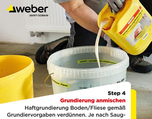
Haftgrundierung Boden/Fliese gemäß Grundiervorgaben verdünnen. Je nach Saugfähigkeit und Beschaffenheit des Untergrundes beträgt der Verbrauch ca. 0,2-0,4 Liter der fertigen Mischung pro qm.
