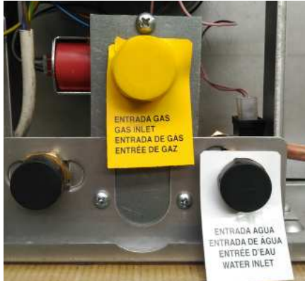
fig. 10 - Tarjetas de conexiones
