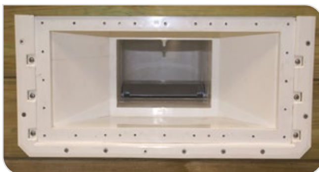
Skimmer bündig gegen den Flansch
