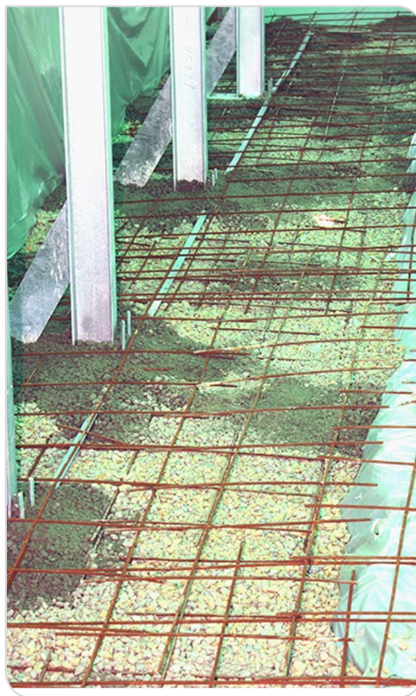
Abbildung 10 – Giessen der Betonplatte (b)
