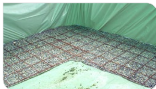
Abbildung 3 – Boden des Aushubs
