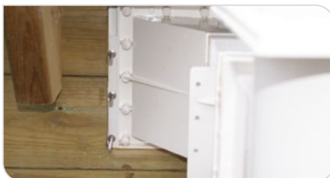
Befestigung des Skimmers
