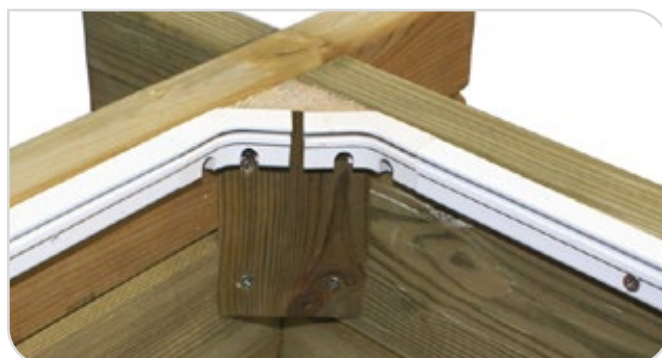
Abbildung 26 – Klemmprofil bündig mit der Beckenoberkante abschließen
