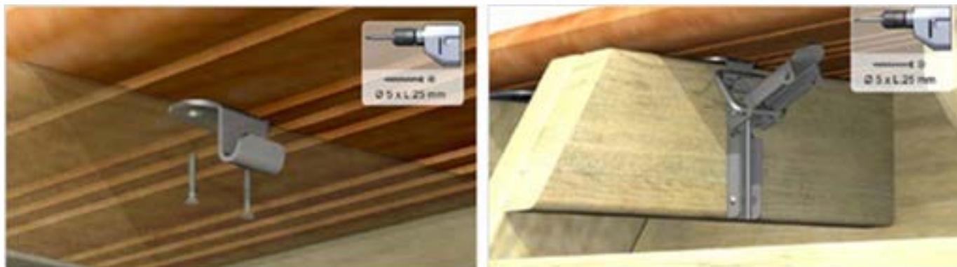
Abbildung 37 – Montage des Systems von Haken und Riegeln
