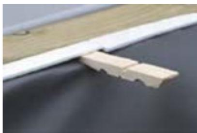
Fixieren Sie die montierten Elemente fortlaufend mithilfe halber Wäscheklammern aus Holz (nicht im Lieferumfang enthalten), insbesondere an den Ecken (*Abbildung 27*).
