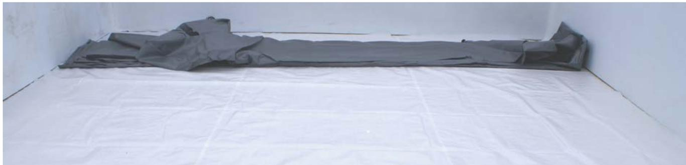
Abbildung 26 – Entfalten der Folienauskleidung
