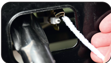
Reinigung des Pilotbrenners mit Hilfe eines Chenilledrahts oder Pfeifenreinigers.
