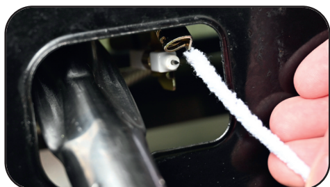
Rengjøring av pilotbrenneren med en chenilletråd eller en piperenser.
