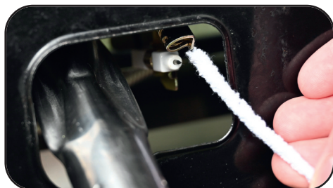
Čištění pilotního hořáku pomocí žínkového drátu nebo čističe dýmek.
