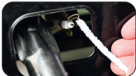
Rengøring af pilotbrænderen med en chenilletråd eller piberenser.
