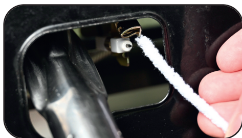
Reiniging van de waakvlambrander met chenilledraad of pijpreiniger
