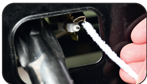
Pulizia del bruciatore pilota servendosi di un filo di ciniglia o di uno scovolino per pipe.
