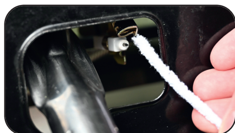
Čišćenje pilot gorionika pomoću šenilne žice ili sredstva za čišćenje cijevi.
