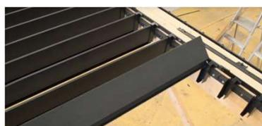
7. Schieben Sie die Lamellen in die Halterungen, indem Sie abwechselnd auf der Seite. Erst links, dann rechts.
