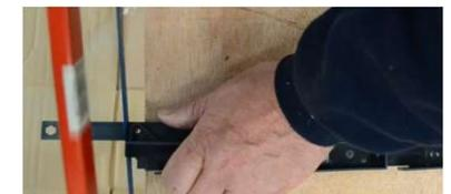
6. Setzen Sie am Ende des Rahmens die letzte Glasleiste mit dem dicken Keil von 7mm ein. Sägen Sie die überflüssigen Stangen ab.
