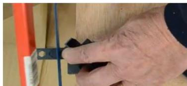
1. Schneiden Sie den Primer-Clip mit einer Metallsäge an.
