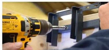
3. Stellen Sie sicher, dass die Stangen nach oben zeigen. Schrauben Sie mit Arretierung am Anschlag.
