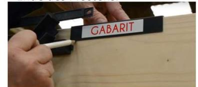
4. Fügen Sie die nächsten Bausätze hinzu, indem Sie die Stangen befestigen. Verschrauben die Glasleisten zusammen. Verwenden Sie dabei immer die Schablone.
