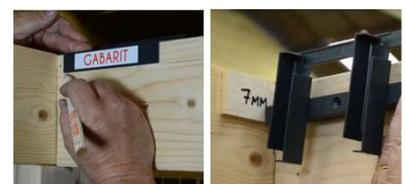
2. Positionieren Sie der Bausatz mit einer Vorlage von 1,5cm von der oberen Kante der Rahmen entfernt. Legen Sie eine 7mm-Keilplatte an das Ende des Pfostens.
