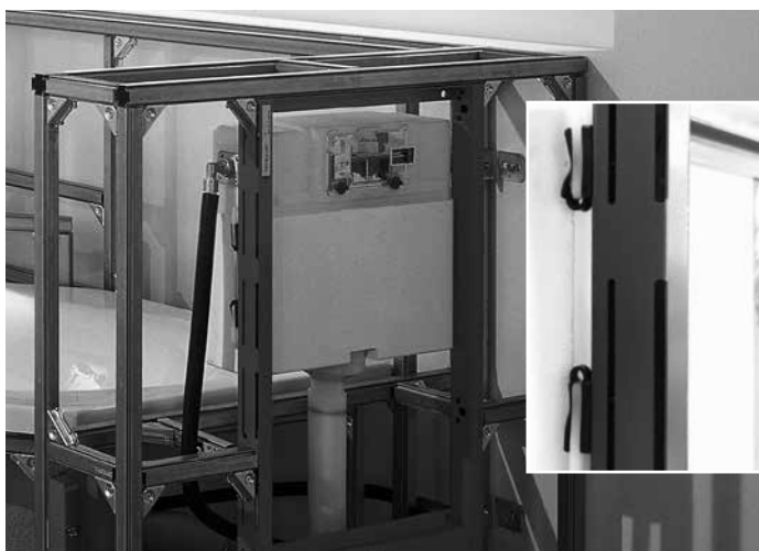
Schallentkopplung des Spülkastens vom Modulrahmen
