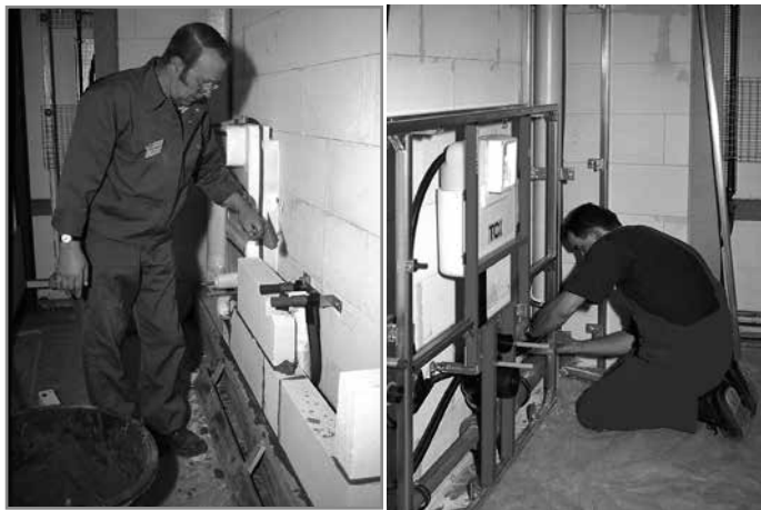
Nassbau (links) gegen Trockenbau
