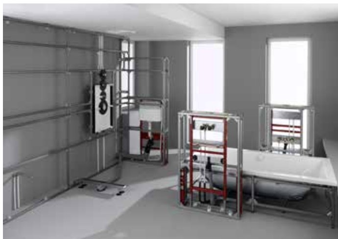
Sanitärwände mit TECEprofil – vorher
