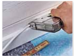
...wenn Kabel befestigt werden.
