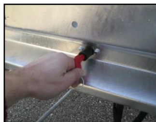
Bild 8: Hauptschalter auf AUS gestellt
