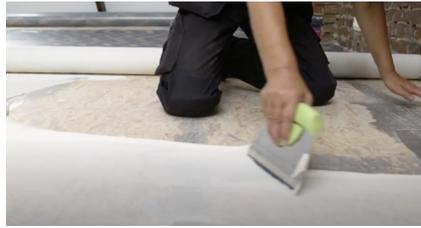
2. Kleber gemäß den Anweisungen des Klebstoffherstellers auf den Unterboden auftragen.
