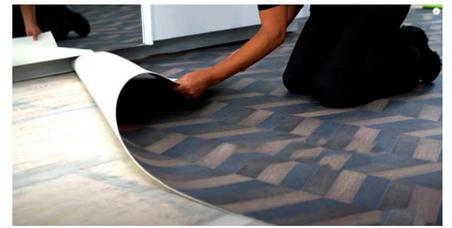
3. Empfohlene Trocknungszeit abwarten und Bodenbelag auf den vorbereiteten Unterboden zurückklappen.
