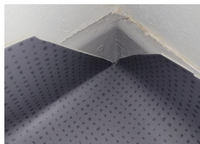
4. Schnitt wie auf der Abbildung gezeigt setzen und Produkt aufklappen.
