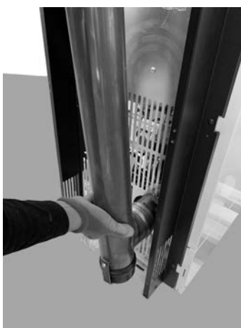
Fig. 49 - Acoplamiento del tubo d. 80 mm
