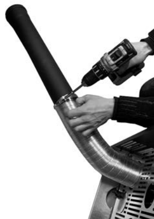
Fig. 63 - Conexión del tubo d. 80 mm
