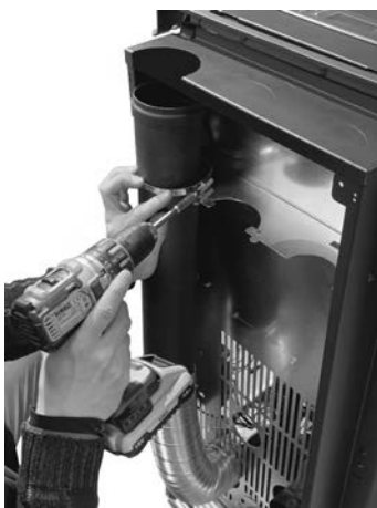
Fig. 65 - Bloqueo del tubo d. 80 mm
