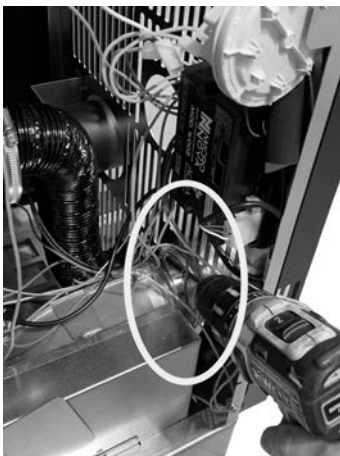
Fig. 62 - Bloqueo del tubo flexible
