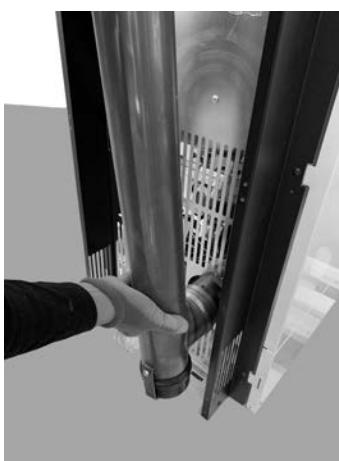
Fig. 43 - Acoplamiento del tubo d. 80 mm
