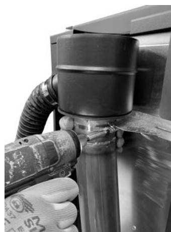
Fig. 50 - Bloqueo con abrazadera
