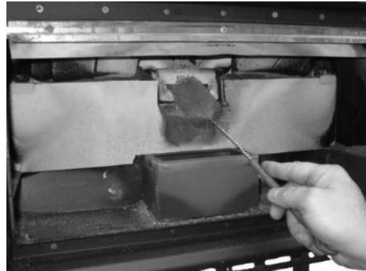
Fig. 48 - Limpieza con escobilla
