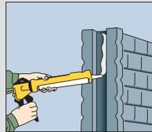
Acrylnaht in die Pfostennut einbringen.
