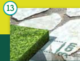
13 Cuando se corte, hay que dejar un sobrante de 3 cm
