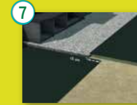
7 Solapar las filas de malla antihierbas unos 15 cm entre las filas
