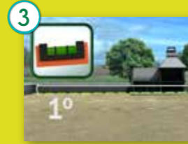
3 Dar pendiente hasta el punto de desagüe con un grado de inclinación
