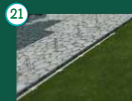
21 Fijar el perímetro de la instalación con grapas cada 50 cm
