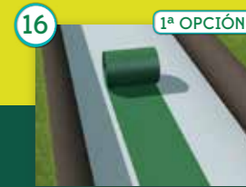
16 Levantar los bordes (15-20 cm). Colocar la banda de solape: BAND
