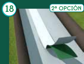
18 Levantar los bordes (15-20 cm). Colocar cinta adhesiva TAPEFIX
