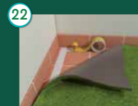
22 Para instalaciones en terrazas utilizar la cinta doble cara TAPEFIX DUPLO para fijar el perímetro
