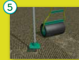
5 Compactar con un rodillo
