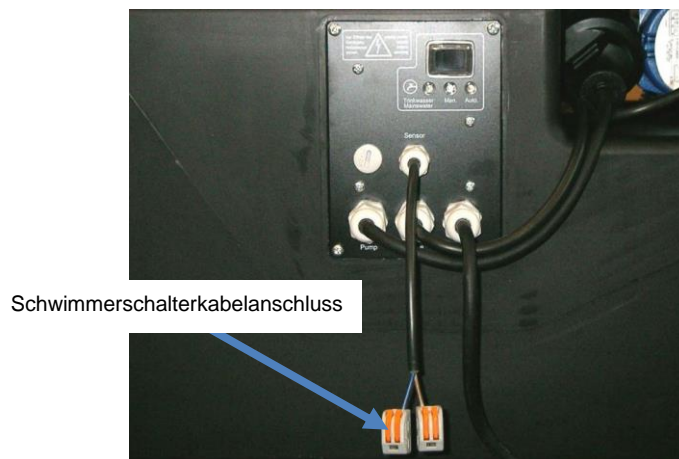
Abbildung 15: Schwimmerschalterkabelanschluss
