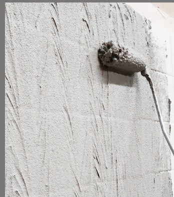
Aplicar una 2ª y 3ª capa si es necesario, dejar secar 2 horas entre una capa y otra.
