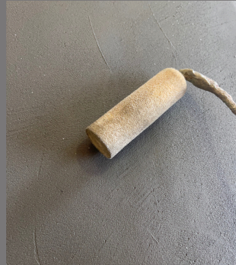
Aplicar 2 capas de Fleur Cement Consolidator
