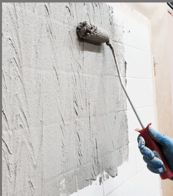
Resin Kit Cement Look aplicar 1 capa con rodillo y alisar con espátula. Dejar secar durante 2 horas.
