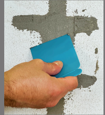
Resin Kit Cement Look: rellenar las juntas con un pincel y alisar con una espátula. Dejar secar durante 2 horas.
