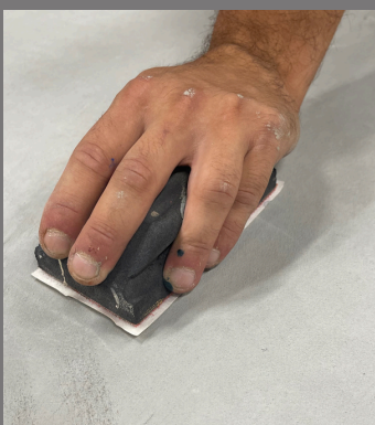
Lijar con abrasivo de grano 120 si es necesario.
