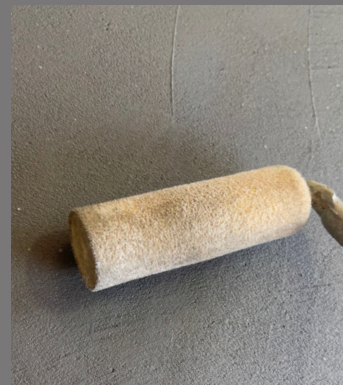
Aplicar 2 capas de Fleur Resina de Acabado o Fleur Resina Extra Resistente.
