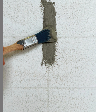
Resin Kit Cement Look: rellenar las juntas con un pincel y alisar con una espátula. Dejar secar durante 2 horas.
