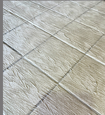
Aplicar 1 capa de Fleur Imprimación Rugosa con un rodillo. Secado 4 horas.
