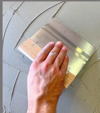
Resin Kit Cement Look aplicar 1 capa con rodillo y alisar con espátula. Dejar secar durante 2 horas.
