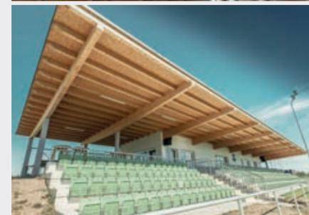
**BRETTSCHICHTHOLZ** ist bei gleicher Tragfähigkeit leichter als Stahl. Die natürliche Kraft des Holzes ermöglicht eine schlanke Dimensionierung der Bauteile.
