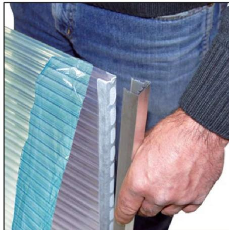
Den Kantenschutz oben und unten über die Kanten schieben. Darauf achten, dass die Tropfnase an der Unterseite (nicht foliert) der Platten liegt.
