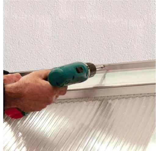
Wandanschluss mit geeigneten Schrauben befestigen.
