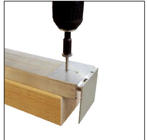
Die 40x40 Haltewinkel mit den 4,8x32 Schrauben an das untere Ende der Schraubprofile anbringen. Der überstehende Winkel kann dann mit einer Zange abgebrochen werden.
