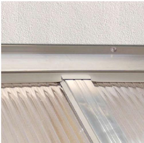
Das Dichtgummi an den Profilen einschneiden, damit es besser anliegt und abdichtet.
