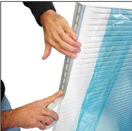
Das Filterband oben und das Filterband mit Membran unten jeweils an den Kanten anbringen. Das Band lieber überstehen lassen, als dass es nicht jede Kammer schützt.
