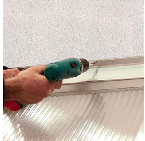
Wandanschluss mit geeigneten Schrauben befestigen.
