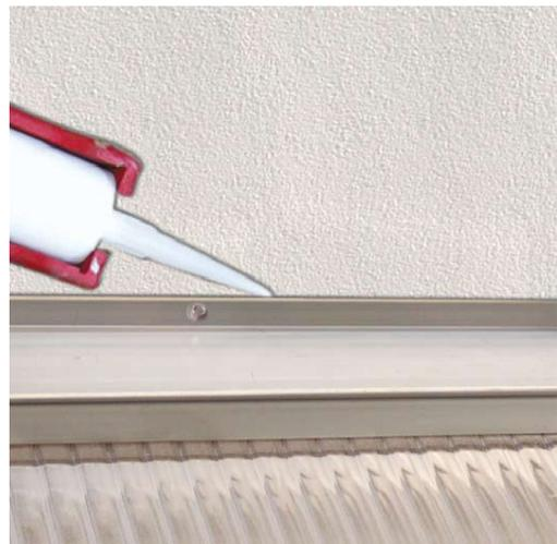
Dichten Sie im letzten Schritt die Fuge zur Wand mit UV beständigem Silikon ab.
