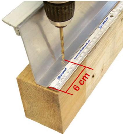
Den Wandanschluss im Durchmesser der verwendeten Schrauben vorbohren. Die erste Bohrung erfolgt nach ca. 6cm. Alle weiteren alle 40cm.
