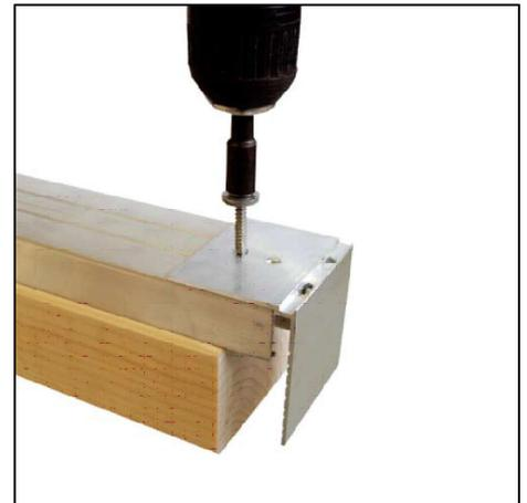
Die 40x40 Haltenwinkel mit den 4,8x32 Schrauben an das untere Ende der Schraubprofile anbringen. Der überstehende Winkel kann dann mit einer Zange abgebrochen werden.
