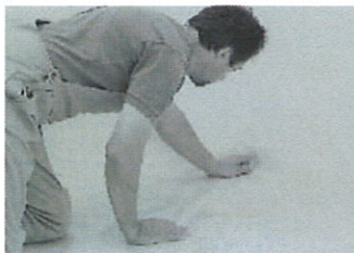
V osnovi je treba za estrihe in pri polaganju na talno gretno položiti PE folijo debeline 0,2 mm.
