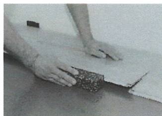
Po potrebi rahlo potrkajte s točilnim blokom.
