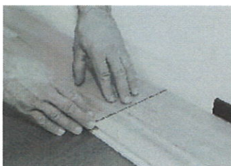
Ostale elemente prve vrste zaskočimo v prejšnjo desko od zgoraj na čelnih koncih. S kratkim pritiskom na križni spoj se element zaskoči v sosednji element.
