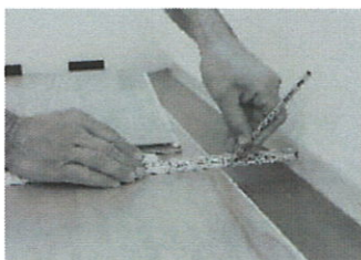
Elementi zadnje vrstice so razrezani in nameščeni vzdolž dolge strani, pri čemer je treba upoštevati raztezno režo 10-15 mm.
