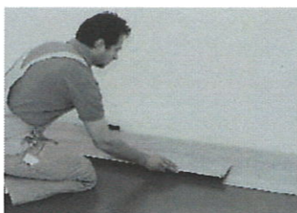
Preostali kos iz prve vrste se uporabi za ponovni začetek v naslednji vrsti (sprednji odmik vsaj 50 cm). To znatno zmanjša količino odpadkov.
