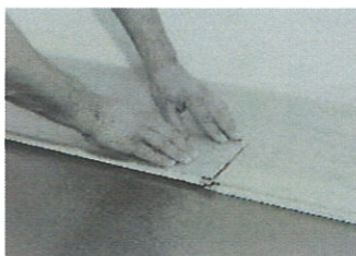
Element se nato spredaj spusti. Prepričajte se, da je sprednja stran elementa poravnana s predhodno nameščenim elementom. S kratkim pritiskom na križni spoj se element zaskoči.
