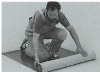
Za izolacijo pred udarnim zvokom in za kompenzacijo manjših neravnin je 2 mm debela udobna izolacijska podloga poravnana z valjanjem. Ustrezne izolacijske podloge najdete v naši ponudbi dodatne opreme. Bitumenski papir ni primeren za izolacijo udarnega zvoka. Parket z laminirano izolacijsko podlago ni primeren za lepljenje po celotni površini.
