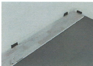
Začenši v desnem kotu sobe so elementi postavljeni z Položen z vzmetno stranjo proti steni in pritrjen z distančnimi klini ali distančniki (dilatacijska razdalja do stene 10 – 15 mm).
