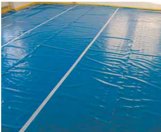
Abbildung 1: PE-Folie überlappt und verklebt
