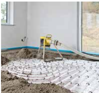
Abbildung 16: Einbringen des Estriches
