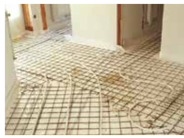
Abbildung 15: Gittersystem
