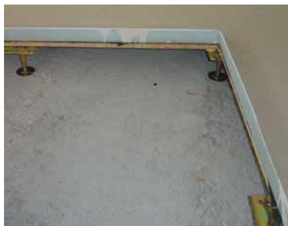
Abbildung 6: Hohlraumboden mit Baumit FließEstrich CSFE 300
