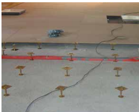
Abbildung 5: Vorbereitung Hohlraumboden
