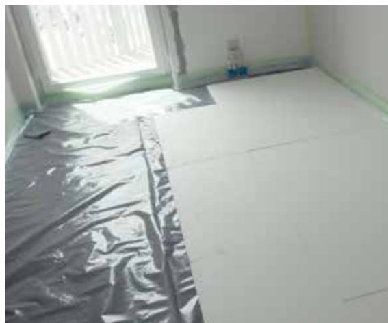
Abbildung 12: Dampfbremssfolie mit Trittschalldämmplatte EPS-T
