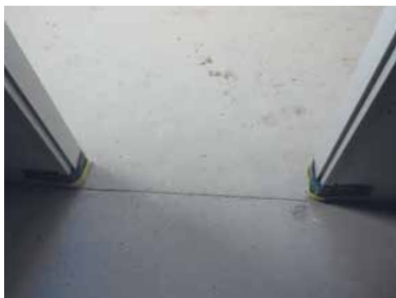
Abbildung 3: Scheinfuge Baumit Estrich E 225
