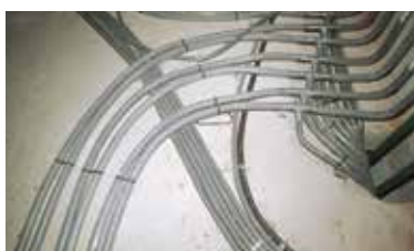
Abbildung 7: Untergrund mit Rohrleitungen
