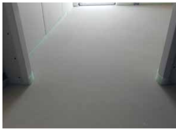
Abbildung 4: Scheinfuge Baumit FließEstrich CSFE 225
