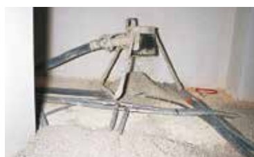
Abbildung 8: Gebundene Beschüttung
