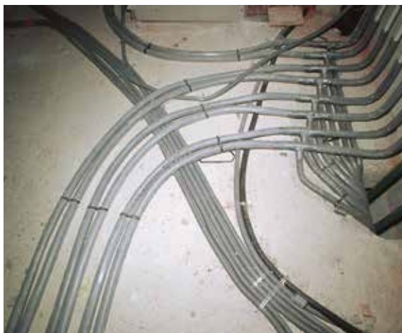
Abbildung 9: Untergrund mit Rohrleitungen
